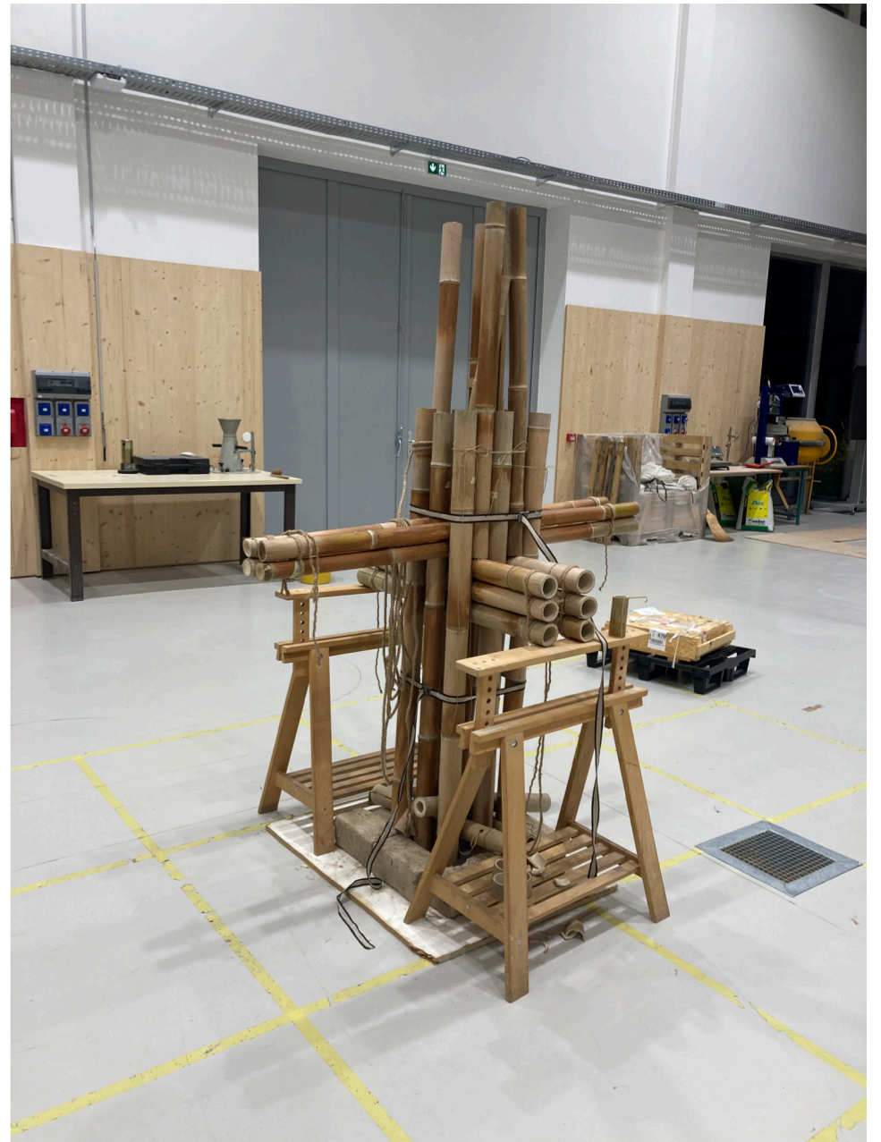
Mise en place et ligatures
